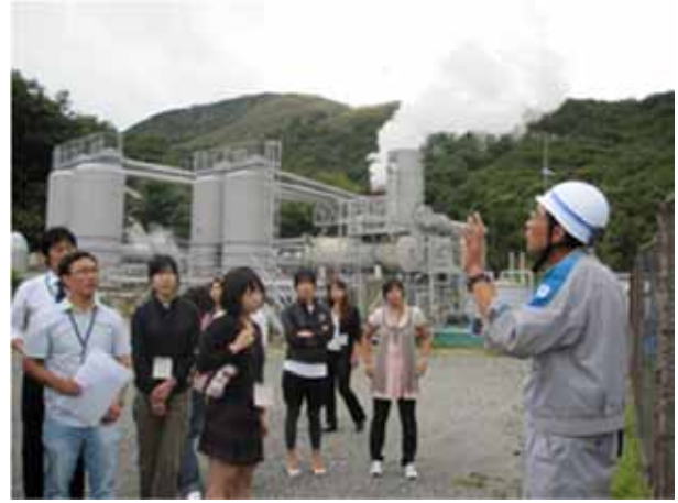
(バイナリー発電所全景)
